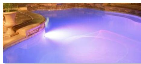
Les lampes LED s'installent en lieu et place des lampes à incandescence traditionnelles quelle que soit leur technologie pourvu qu'elles soient au format PAR56.
